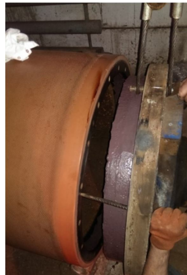
Рис. 14. Монтаж цапфы на вал
