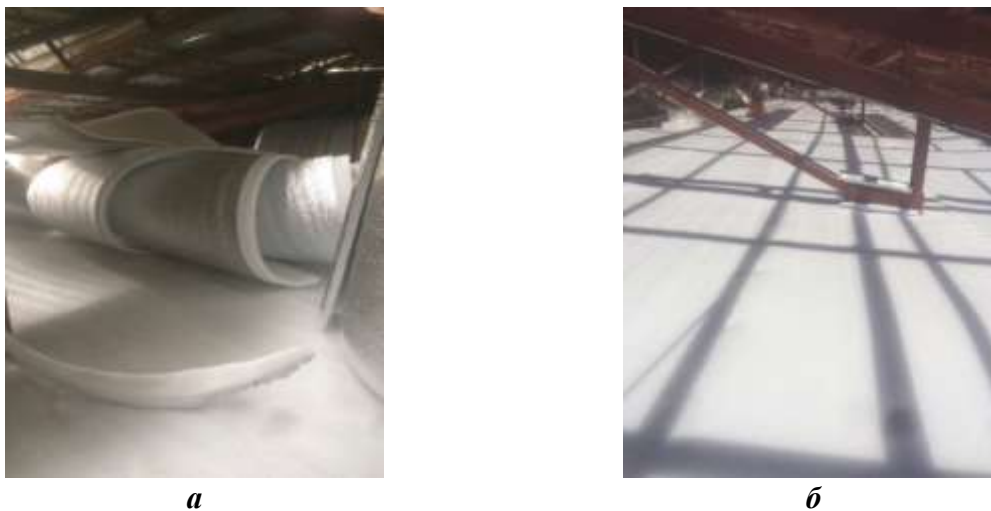
Рис. 2. Изоляция крыши: а – рулоны пенополиэтилена; б – уложенная изоляционная оболочка
