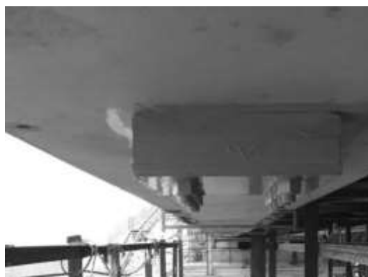
Рис. 2. Внешний вид композитного шпренгеля на нижнем поясе пролетного строения
