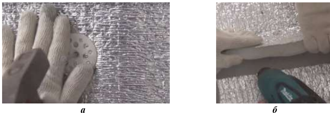
Рис. 1. Монтаж теплоизоляции: а – механическое закрепление листа утеплителя; б – сварка стыков рулонного пенополиэтилена
