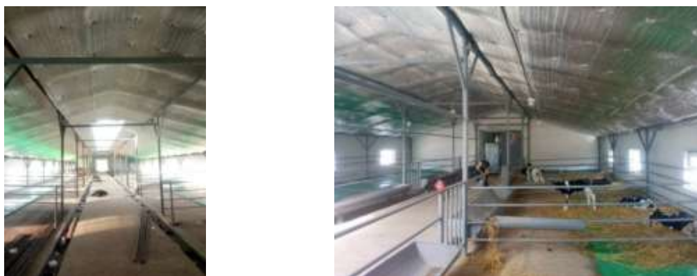
Рис. 3. Изоляция каркасного помещения. Телятник
