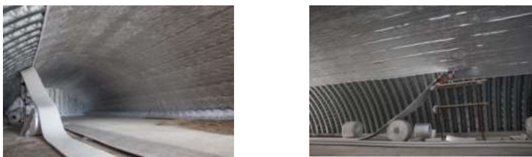
Рис. 1. Монтаж изоляционной оболочки ангара
