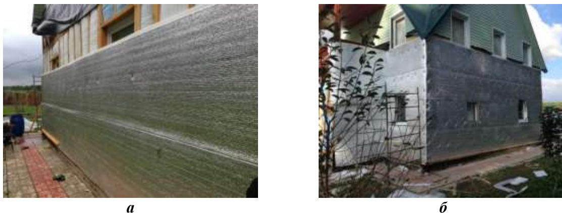
Рис. 4. Формирование изоляционной оболочки каркасного коттеджа: а – монтаж рулонного пенополиэтилена и сшивка швов; б – формирование изоляционной оболочки и оконных проемов
