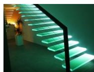
Рисунок 2 – Применение триплекса для создания лестничных ступеней
