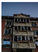
Рисунок 1 – Современный фасад жилого здания. Алма-Ата. 2010-е гг.
