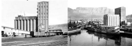
Рисунок 1 – Элеваторное зернохранилище, Кейптаун, ЮАР
