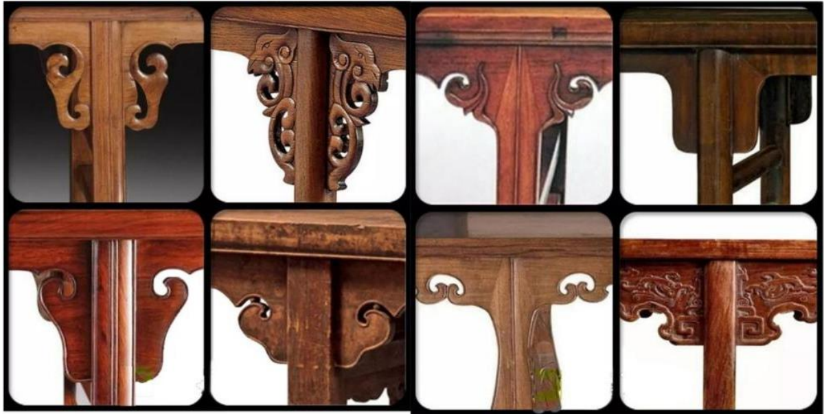
Рис. 16. «Вставное плечевое соединение» стола или тип мебельной конструкции
