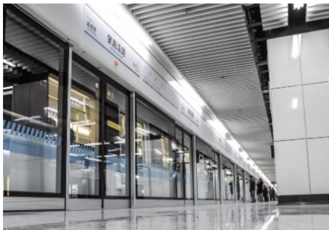
Рисунок 2.1 – Платформенные раздвижные двери. Станция «Чжэньхуа Роуд» 3-й линии циндаоского метрополитена, 2015 г. Источник изображения: https://mt.sohu.com/20160517/n450017404.shtml
