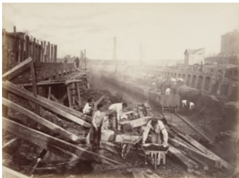
Рисунок 1.1 – Первая линия Лондонской мелкого залегания строилась открытым способом. 1861 г. Источник изображения: https://transport.mos.ru/mostrans/all_news/19500
